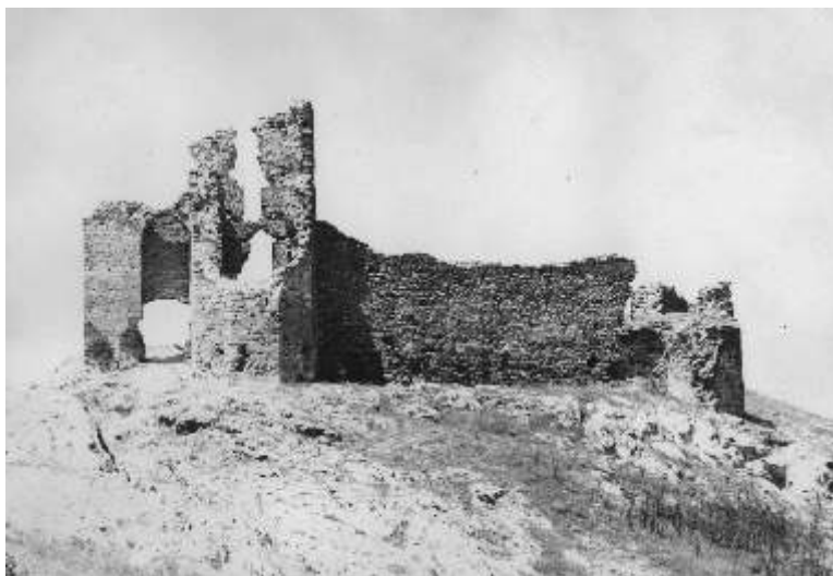
Fig. 2. Castelul Ienisala, vedere de ansamblu ( foto Gr. Avachian, 1939 )
