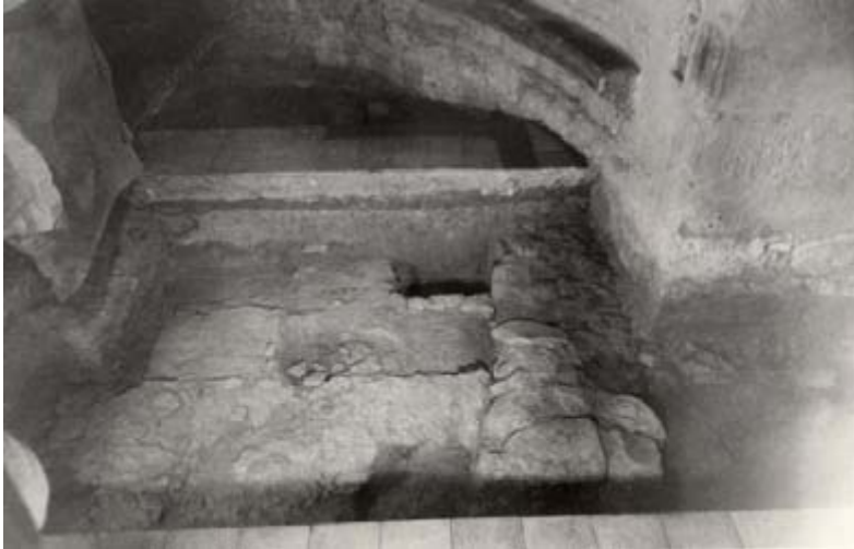
Fig. 1. Resturile stratului-suport al pardoselii ini iale din dale p trate de piatr
