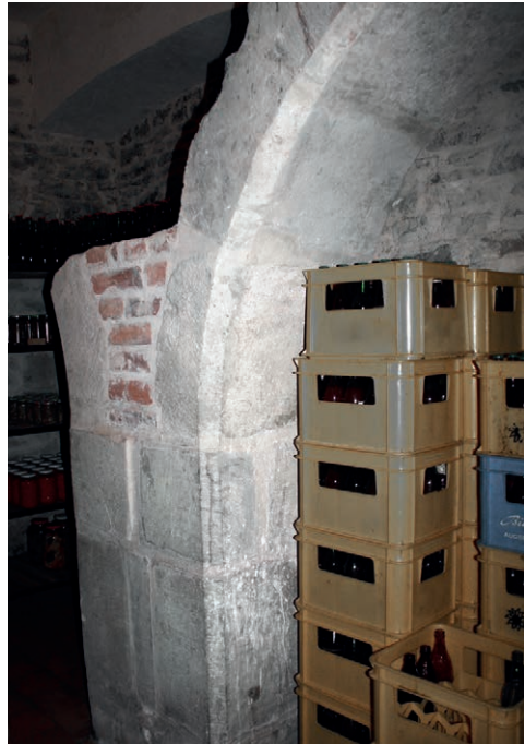
Fig. 84. Stâlp și geneza arcelor din construcția medievală, astăzi în beciul „Casei domnești”
