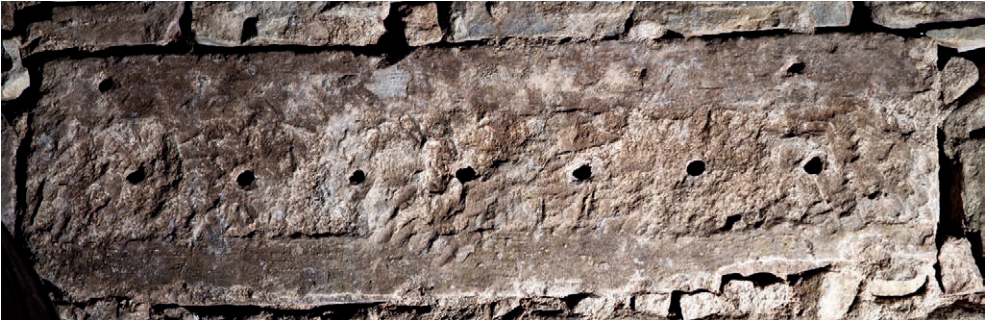
Fig. 88. Bloc din componența unei ferestre cu zăbrele metalice, refolosit în zidăria actuală
