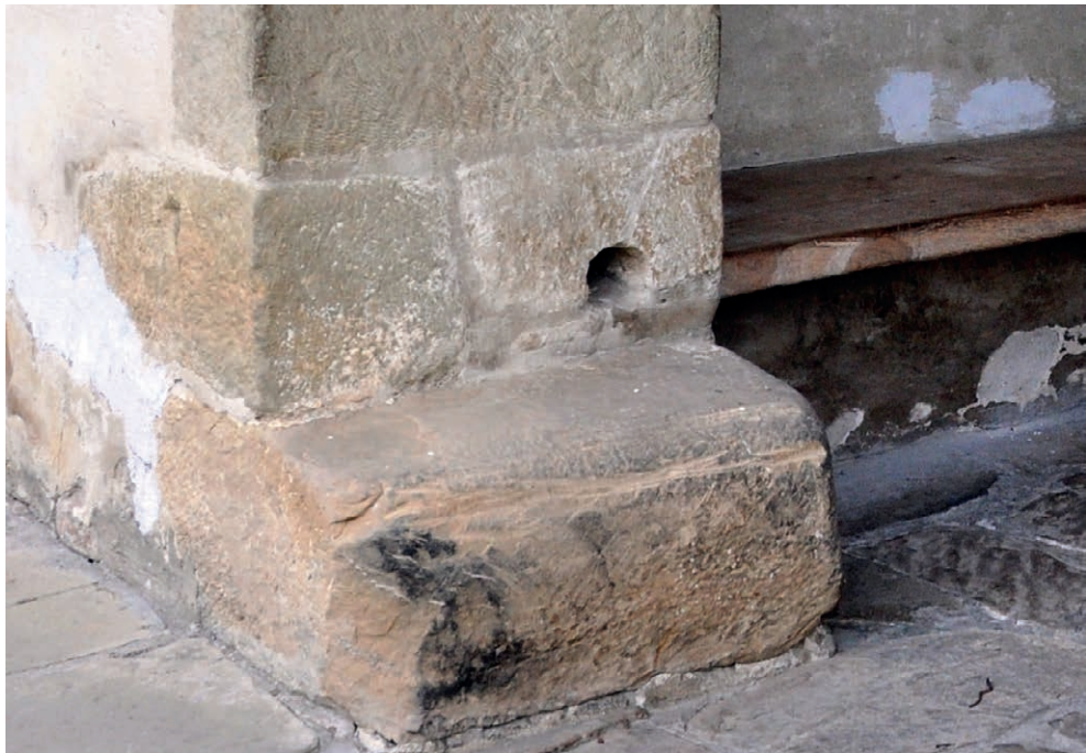
Fig. 150. Bloc de piatră, original, probabil, din componența unui sistem de aducțiune a apei, refolosit la turnul de intrare
