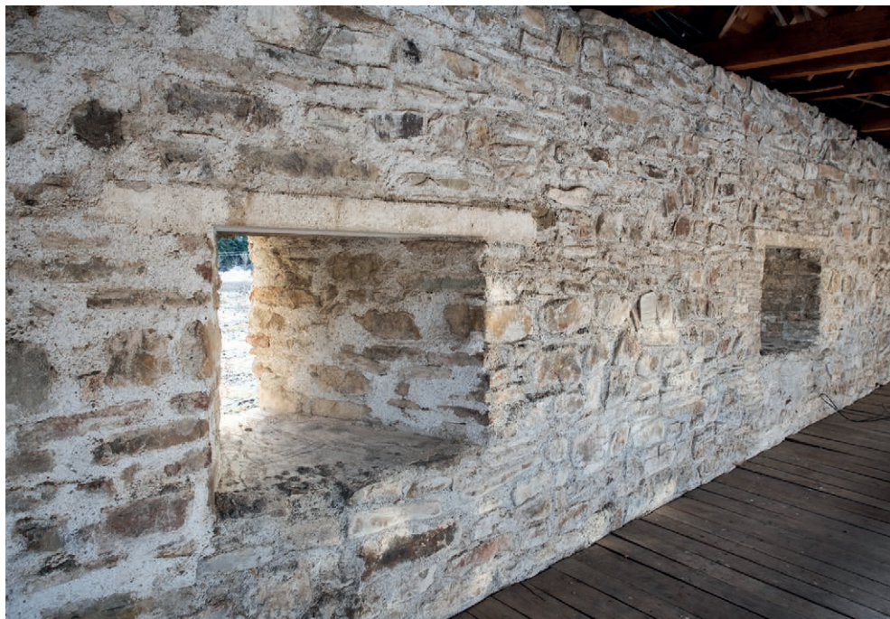
Fig. 94. Golurile de tragere în zidul de incintă, refăcute în cursul secolului al XX-lea
