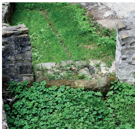
Fig. 73. Prag de ușă cu urme accentuate de uzură
