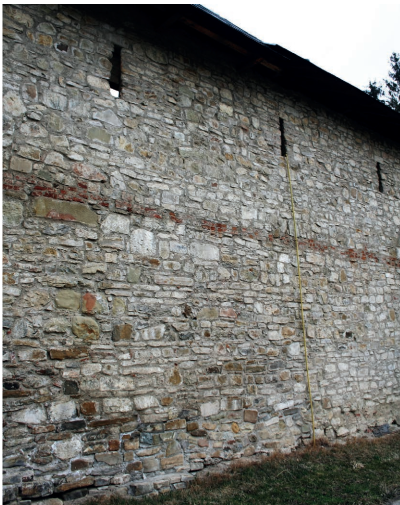
Fig. 92. Bandă de asize din cărămidă, latura de sud a zidului de incintă
