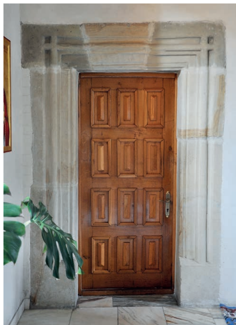
Fig. 80. Ancadrament de ușă în care au fost integrate blocuri profilate originale
