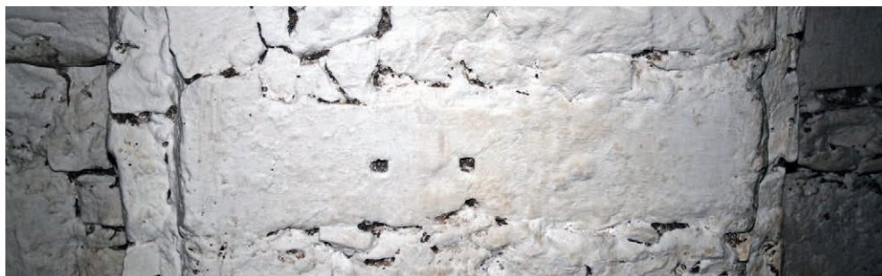
Fig. 87. Bloc din componența unei ferestre cu zăbrele metalice, refolosit în zidăria actuală
