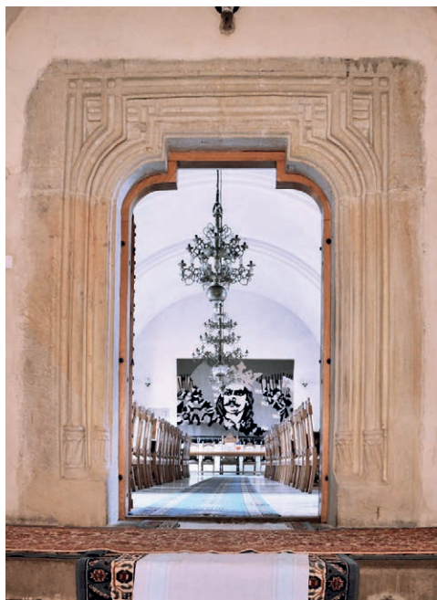
Fig. 79. Ancadrament gotic cu linteal original și montanți refăcuți, intrarea în „Sala tronului”
