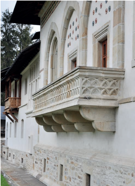
Fig. 83. Terasa/logia de pe latura de nord a „Casei domnești”
