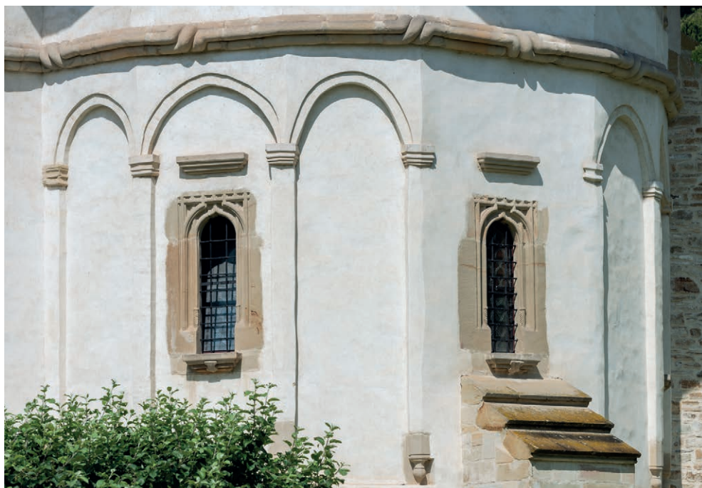
Fig. 33. Consolele arcelor decorative în exteriorul altarului
