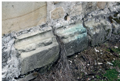
Fig. 55. Soclul inferior profilat, detaliu
