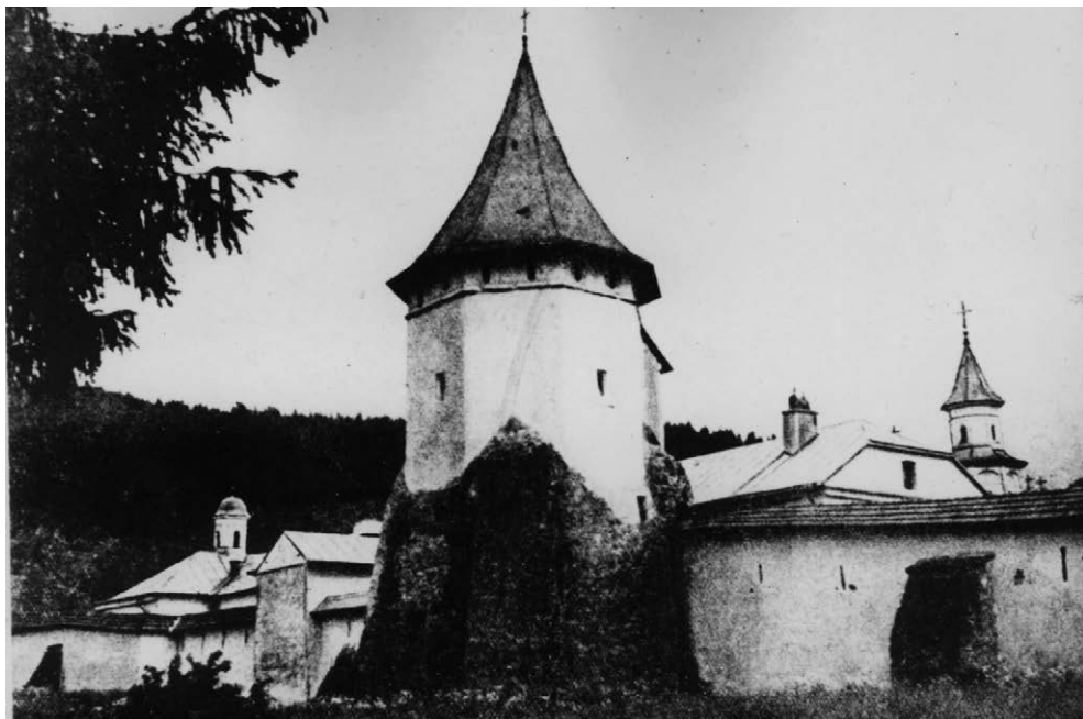
Fig. 43. Turnul Tezaur cu mașonul de zidărie, înainte de 1958. După Repertoriul monumentelor și obiectelor de artă din timpul lui Ștefan cel Mare , București, 1958, p. 54, fig. 19.
