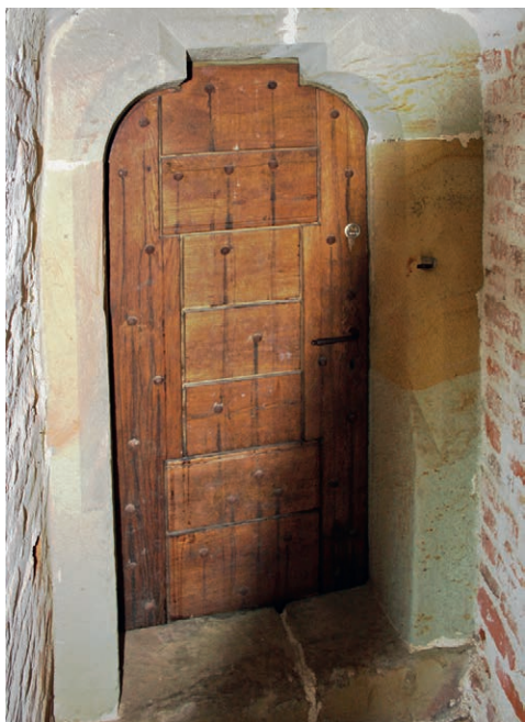
Fig. 49. Ușa de intrare în camera de la etajul al II-lea, vedere dinspre casa scării
