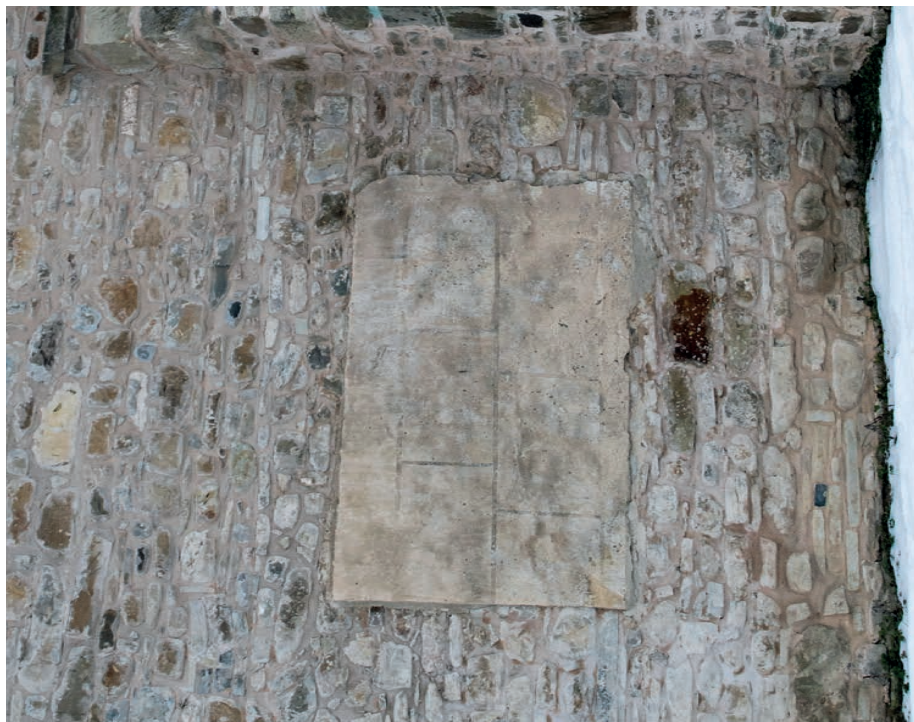
Fig. 104. Fragmente de tencuială „martor”, cu desenul „paramentului ideal” pe fațada exterioară a zidului estic
