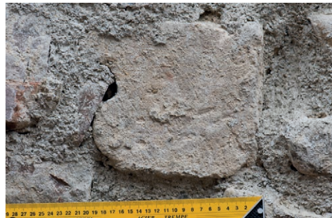
Fig. 112. Bloc cu posibilă profilatură în formă de de baghetă, (re)folosit în zidul de incintă
