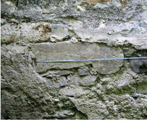
Fig. 108. Treaptă refolosită în zidul incintei
