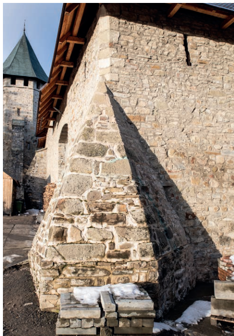
Fig. 99. Contrafortul din colțul de sud-vest
