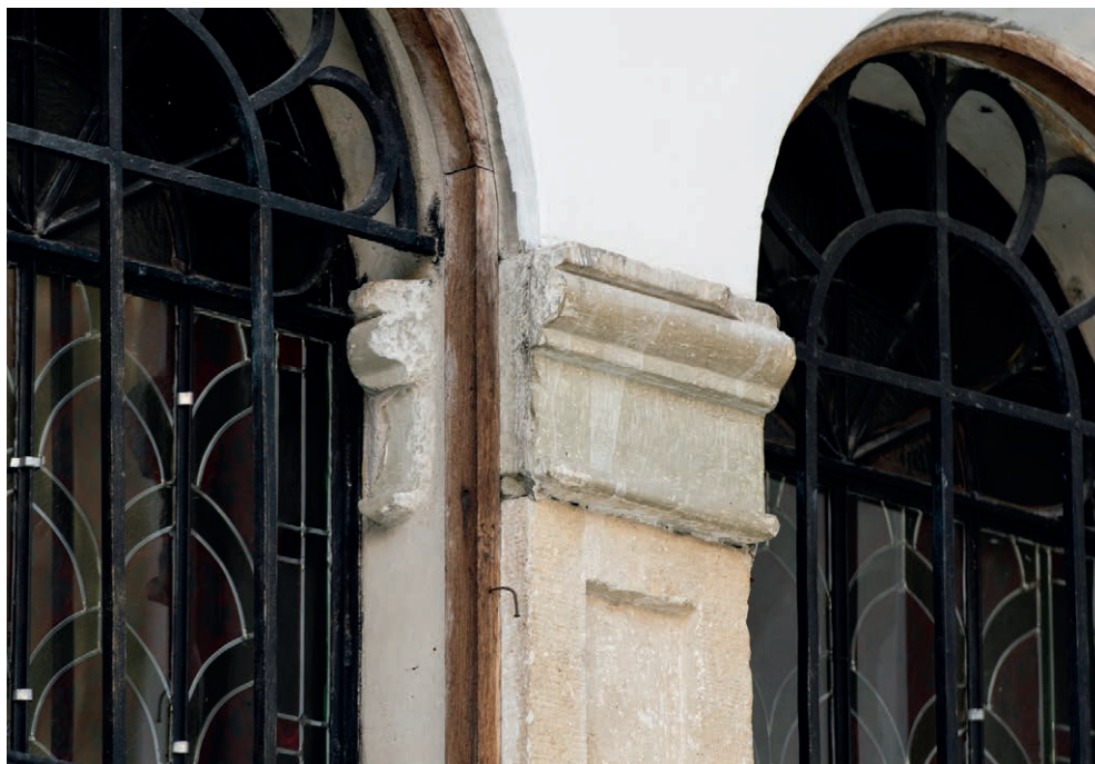
Fig. 115. Piatră profilată refolosită la paraclis
