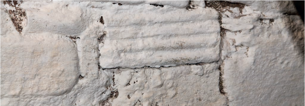
Fig. 89. Bloc cu suprafața traversată de caneluri, refolosit în zidăria actuală
