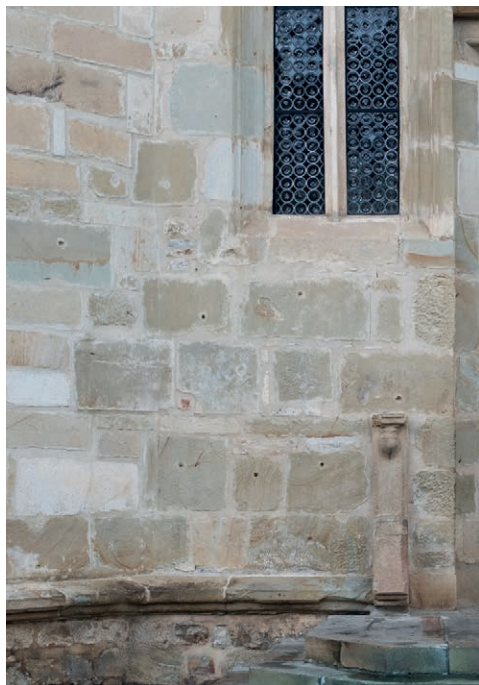
Fig. 7. Pietre cu găuri în paramentul bisericii
