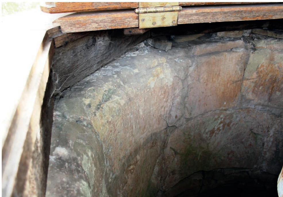
Fig. 149. Coronamentul ghizdului fântâniei, executat din pietre profilate
