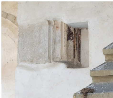
Fig. 25. Piatră refolosită cu urme de pictură; exterior, absida de nord a altarului
