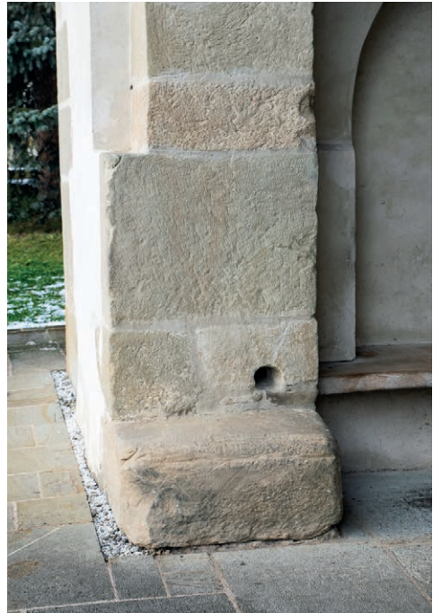
Fig. 68. Pietre reciclate în construcție
