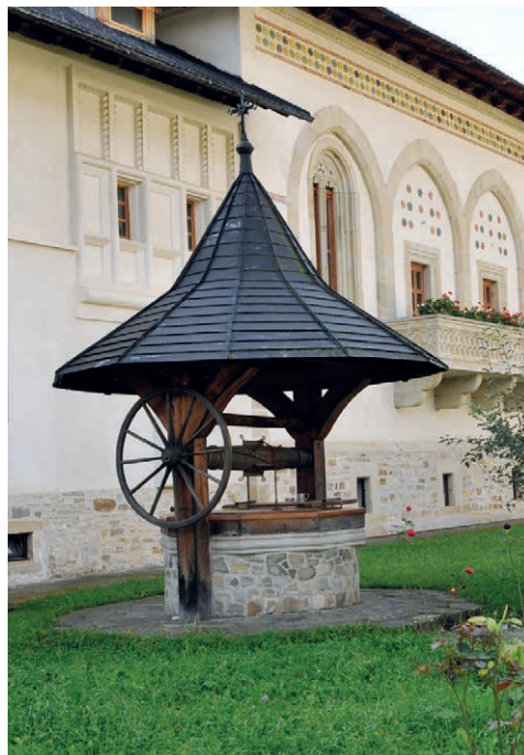
Fig. 148. Fântâna, aspectul actual
