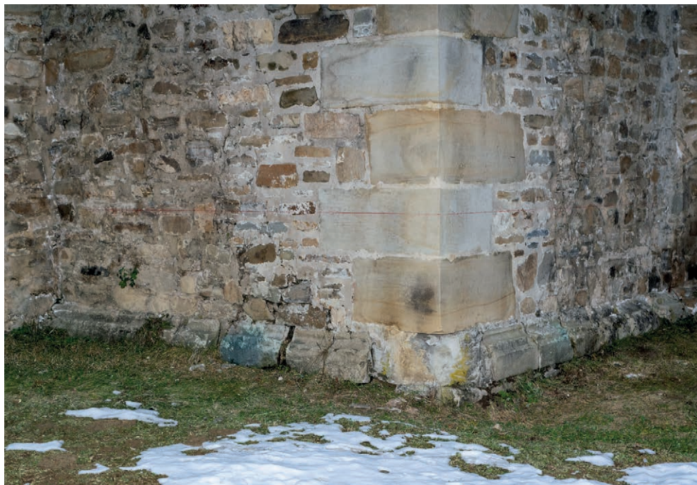
Fig. 45. Turnul Tezaur, soclul inferior, vedere dinspre nord-vest
